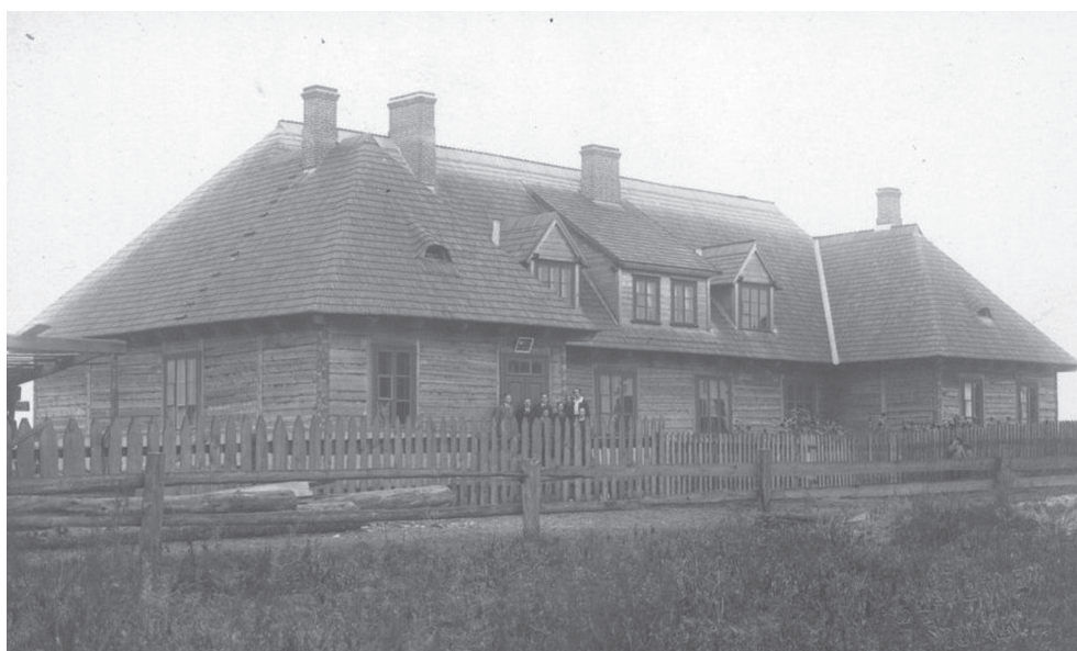
Budynek szkoły powszechnej w Gibach, 1925.
